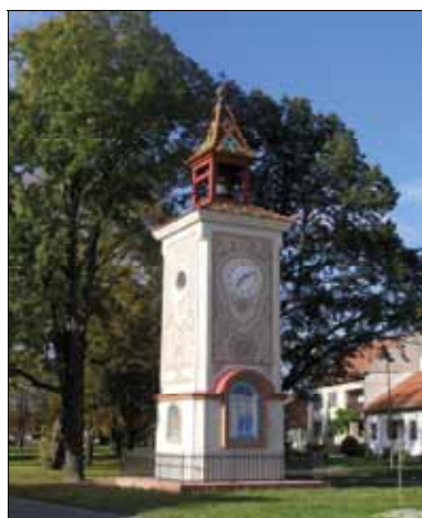
Rekonstrukce zvonice, Uherský Ostroh
