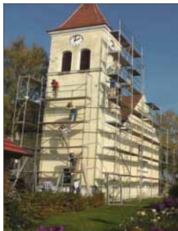
Obnova fasády kostela, Hrubá Vrbka
